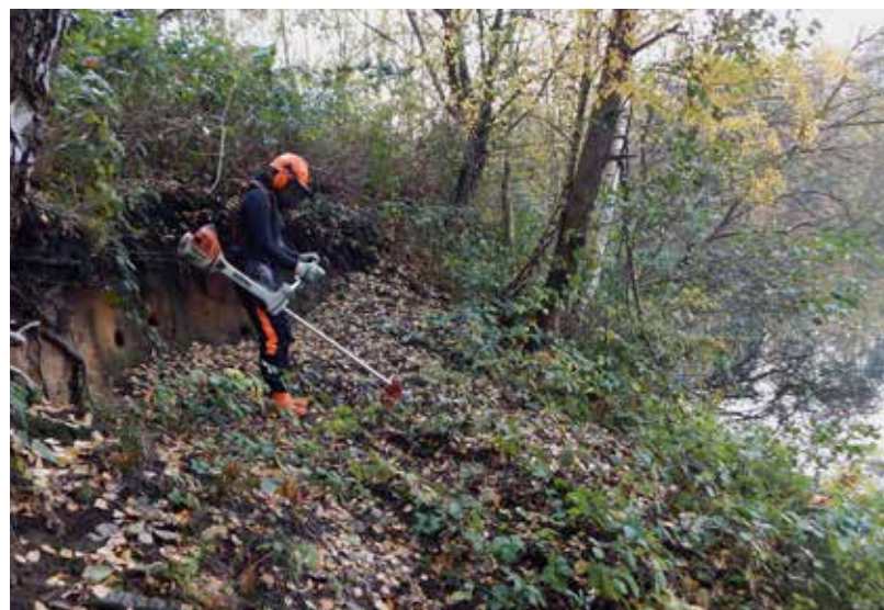
Abbildung 10: Freistellung der Steilwand am 21.11.
