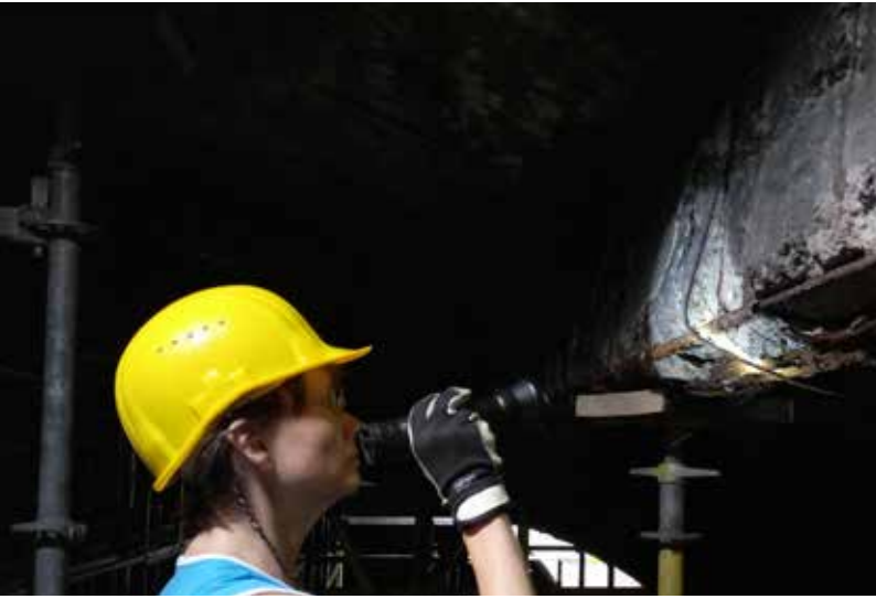
Abbildung 89: Mitarbeiterin der BSWR auf dem Gerüst in der Auftauhalle bei der Kontrolle von Betonspalten
