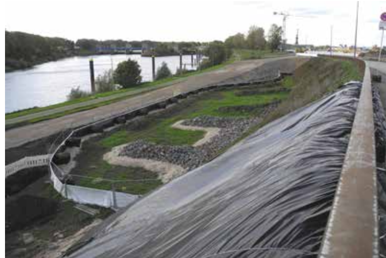
Abbildung 100: Maßnahmen im Rahmen der Bauarbeiten am Pontwert (12.10.)
