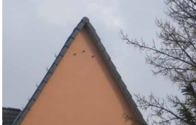
Abbildung 98: In der Spitze des Giebels wurden bei diesem Gebäude im Essener Südostviertel drei Mauerseglerkästen in die Wärmedämmung integriert. (Foto: F. Cassese)
