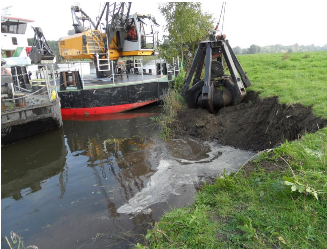
Abb. 2: Aufnahme der Uferbefestigung und Errichtung einer Steilwand bei km 6,66. Foto: J. Meßer
