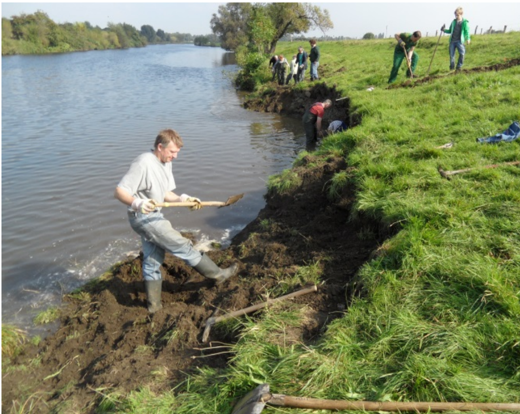
Abb. 4: Feinprofilierung und Entfernung weiterer Wasserbausteine bei km 6,35 durch den BUND. Foto: J. Meßer
