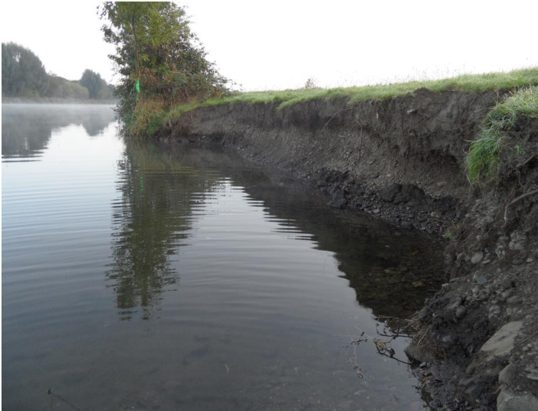
Abb. 3: Steilwand nach Fertigstellung bei km 6,66. Foto: J. Meßer
