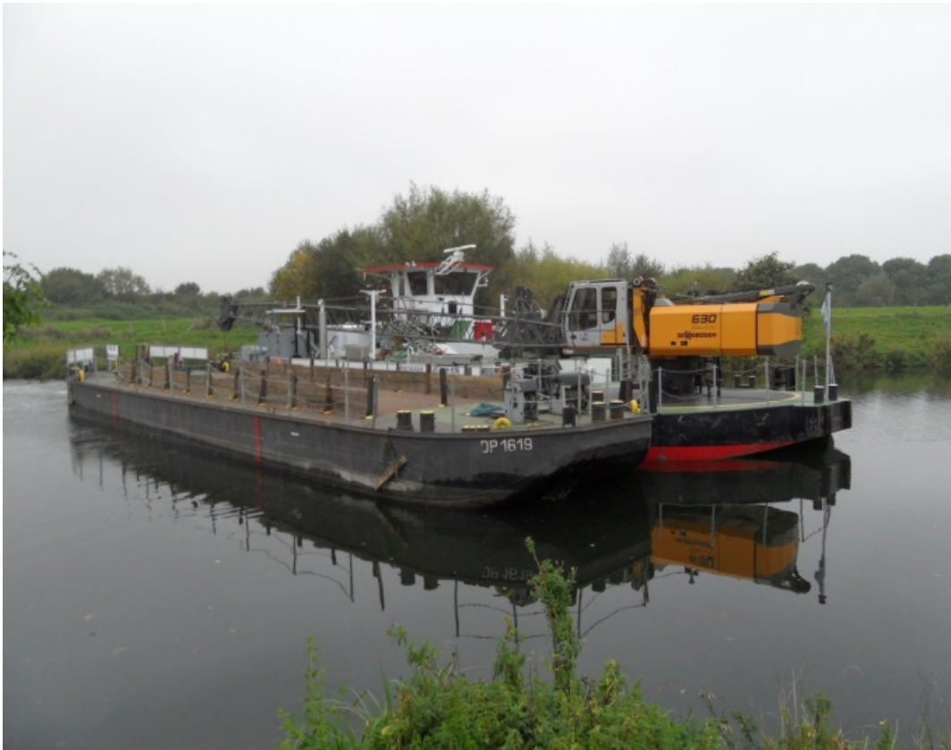
Abb.1: Arbeitsgeräte der Wasser- und Schifffahrtsverwaltung zur Uferentfesselung. Foto: J. Meßer
