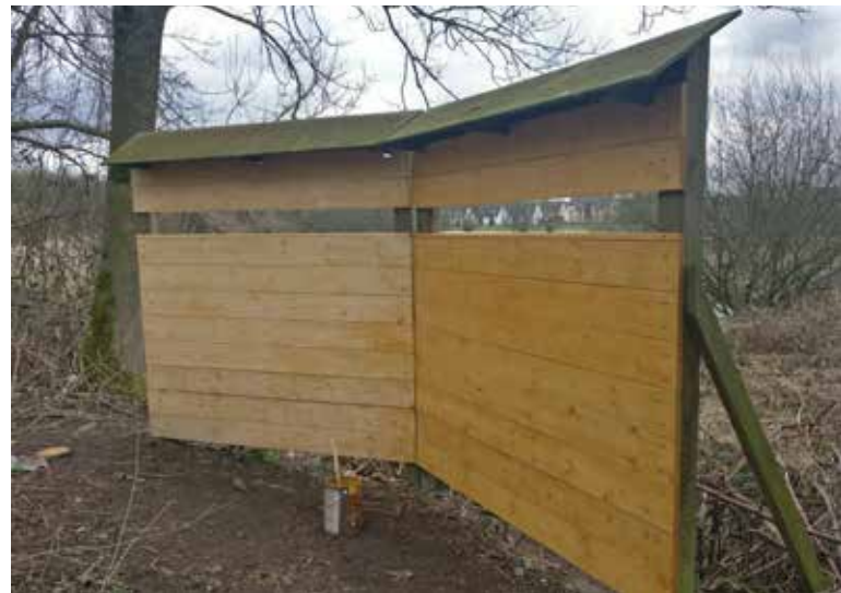
Abbildung 26: Die Vogelsichtschutzwand nach ihrer Neuerrichtung im März 2018
