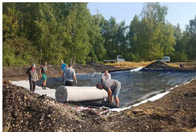
Abbildung 131: Während der Arbeiten an dem neuen Amphibien- und Libellen-Teich im Gleispark Frintrop im Sommer
