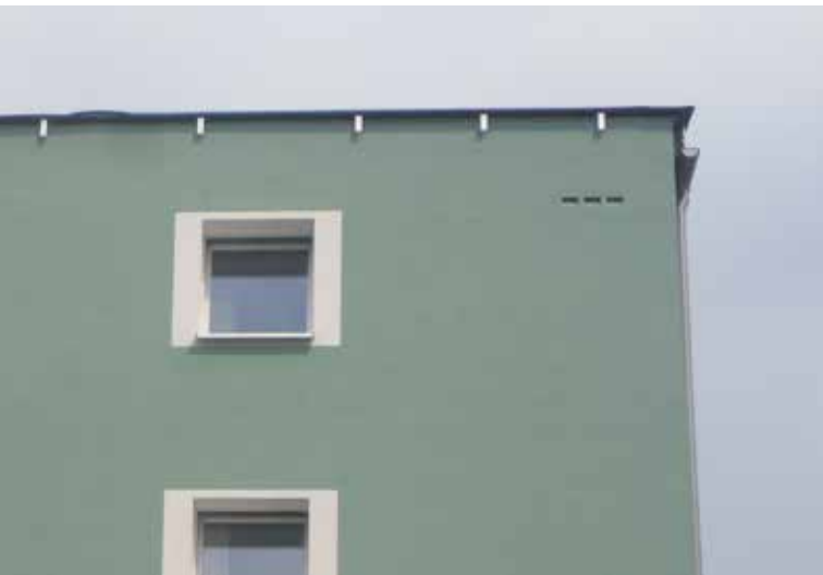
Abbildung 140: In Duisburg Walsum wurden bei der Sanierung eines Wohngebäudes Fledermauskästen in die Fassade integriert.
