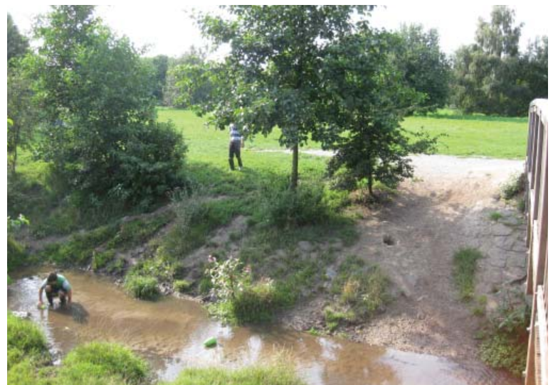
Abbildung 12: Vegetationslose Stellen am Brückenkopf
