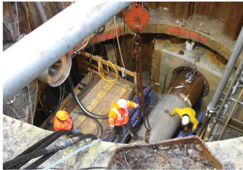
Abbildung 17: Pressgrube für den Abwasserkanal, Januar 2013
