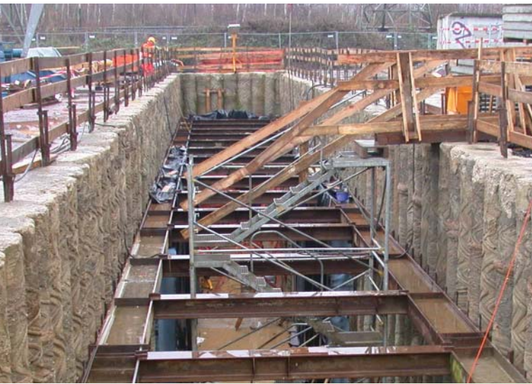
Abbildung 16: Bau der Regenwasserbehandlungsanlage, Dezember 2012
