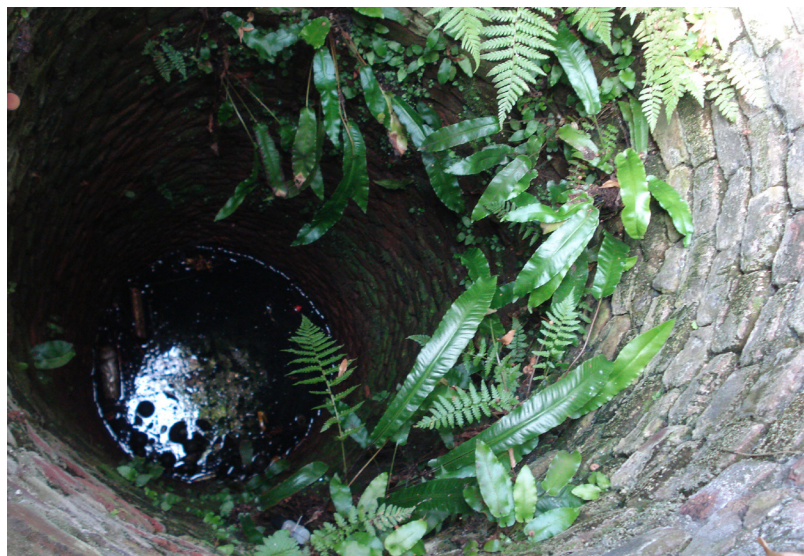
Abbildung 120: Farnbewuchs in einem Brunnenschacht im Kloster Saarn
