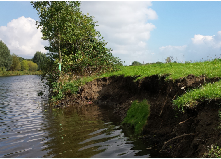
Abbildung 118: Die Abbruchkante am Ruhrufer vor der Nachbearbeitung per Hand
