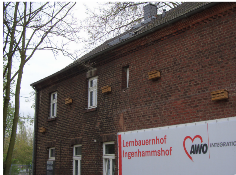
Abbildung 139: Sperlingskästen am Ingenhammshof
