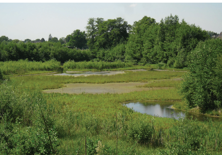
Abbildung 27: Das Regenrückhaltebecken zeigte Anfang Juni 2013 nur wenig offenes Wasser und starke Gehölzsukzession von den Rändern
