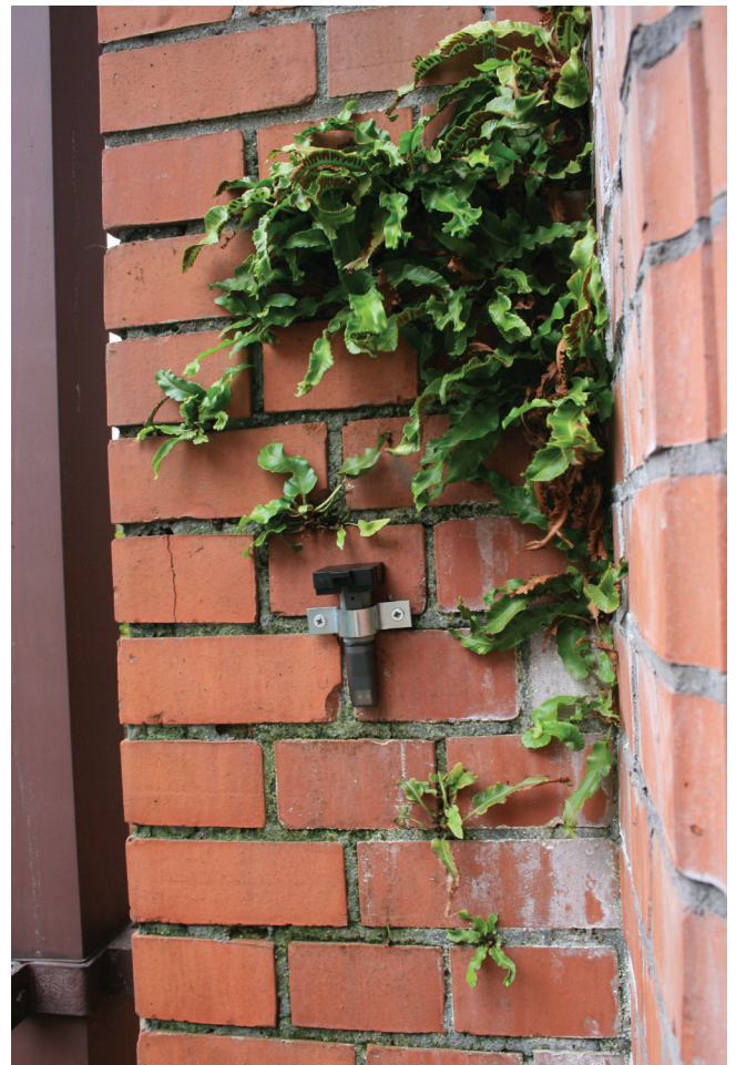
Abbildung 100: Datalogger an der Außenfassade des evangelischen Krankenhauses Mülheim. Der große Bestand der Hirschwurze ( Asplenium scolopendrium ) wurde jedoch Mitte des Jahres bei Sanierungsarbeiten vernichtet
