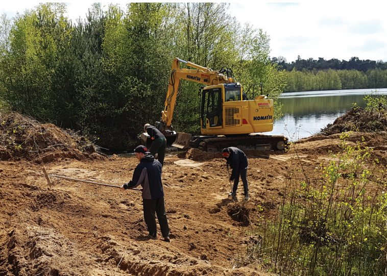
Abbildung 3: Freistellungsmaßnahmen am Haubachsee – neben den Baggerarbeiten ist hier Handarbeit der Bufdis gefragt.
