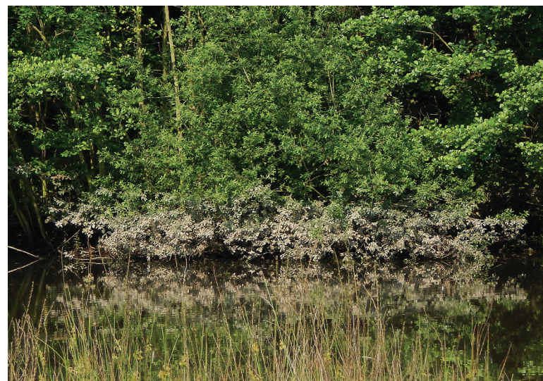
Abbildung 24: Spureneines Hochwasserereignisses am 07.06.16 im Regenrückhaltebecken
