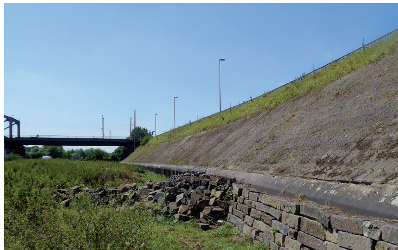
Abbildung 124: Situation am Pontwert nach der Maßnahme (August 16)
