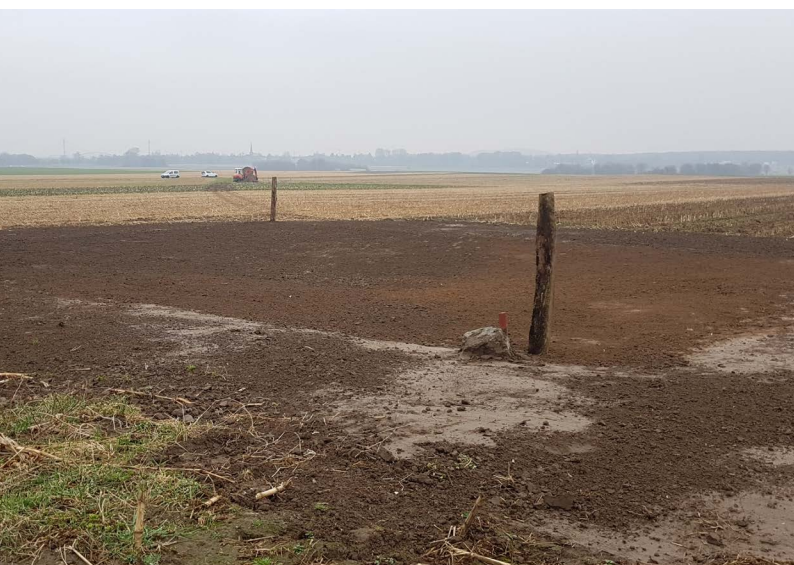
Abbildung 34: Die fertiggestellte Blänke nach Beendigung der Arbeiten
