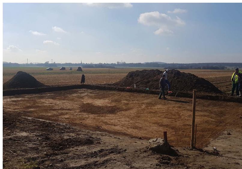
Abbildung 33: Baumaßnahmen an der Blänke im Binsheimer Feld im März
