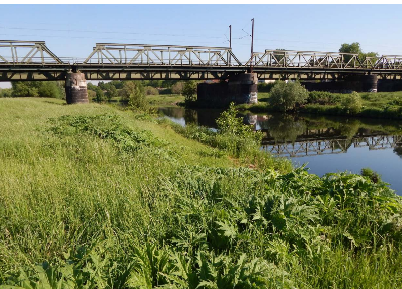
Abbildung 114: Ruhrufer mit aufkommender Herkulesstaude im Mai im Ruhrbogen, im Hintergrund eine der Bahnbrücken
