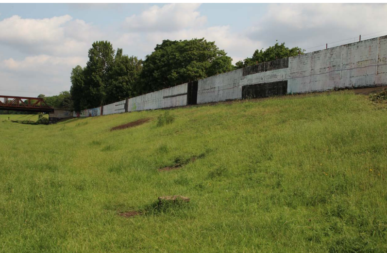
Abbildung 81: Deich im äußeren Ruhrbogen
