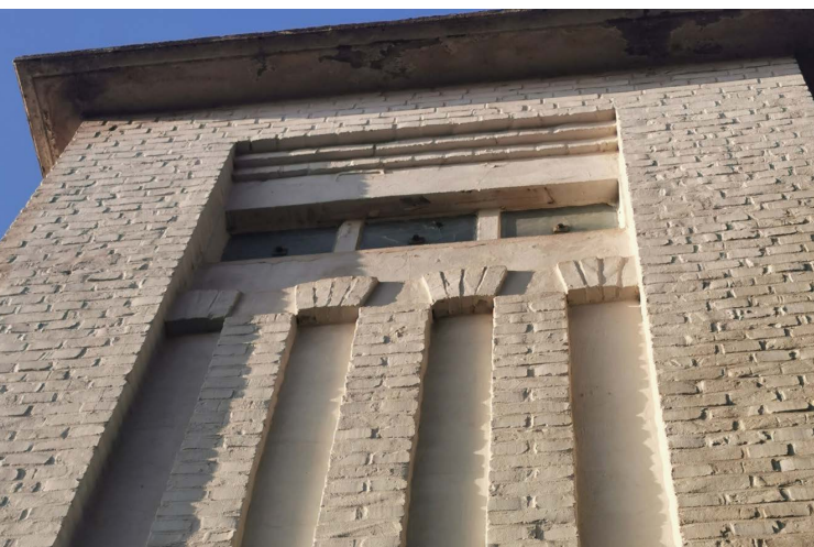
Abbildung 109: Blick von unten auf die Fenster im Traforturm (Foto H. Rempel, RVR)
