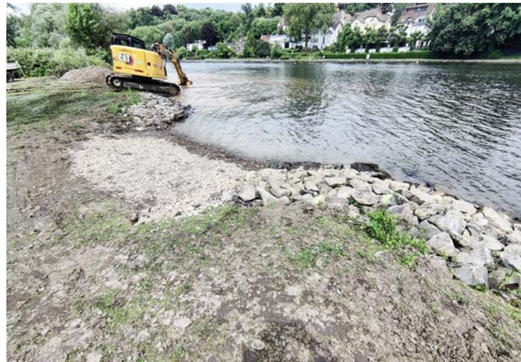
Abbildung 62: Bauliche Maßnahme an der Badestelle im Juni 2024: Im Vordergrund die neu modellierte Einstiegszone und die beeinträchtigte Wiese, im Hintergrund schweres Gerät im Einsatz sowie der angefallene Aushub.
